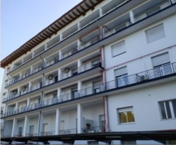
Durante el segundo semestre de 2019, se han realizado obras de rehabilitación y pintado de la fachada norte del hospital, consistentes en la remoción de antiguas estructuras (pilares y terrazas), para su reconstrucción. Asimismo, en las terrazas, se ha construido un nuevo pavimento.
